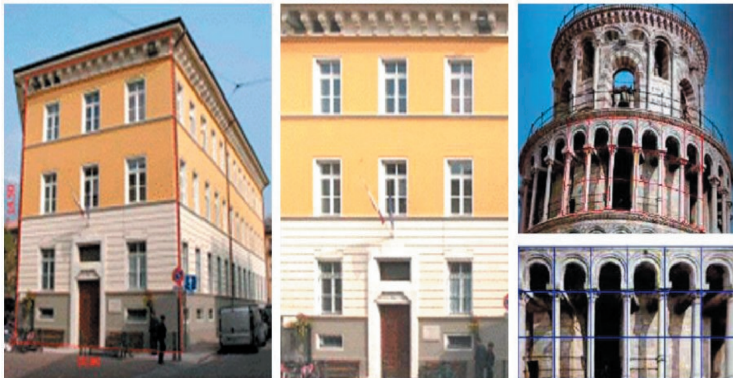
Figura 94 Rilievo di alzato realizzato con raddrizzamento elettronico. (DigiCAD 3D)
